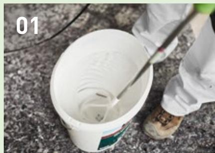
**01 Misturar o material.** A massa de aparelhar é misturada no cesto misturador adequado – as massas de aparelhar em pó, idealmente com aspiração no balde.
